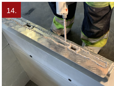
14. Upprepa proceduren med det långa beslaget på motståndesida av brunnen. Var noga med att inte applicera något lim på den nedersta delen, då fastnar beslaget även i den underliggande sektionen.
